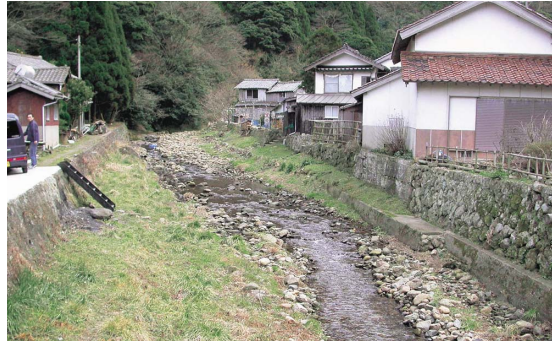
図4 猪目川下流 (猪目川 St.1 の上流側)
